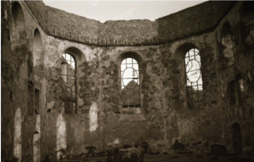
Die zerstörte Martinskirche.
